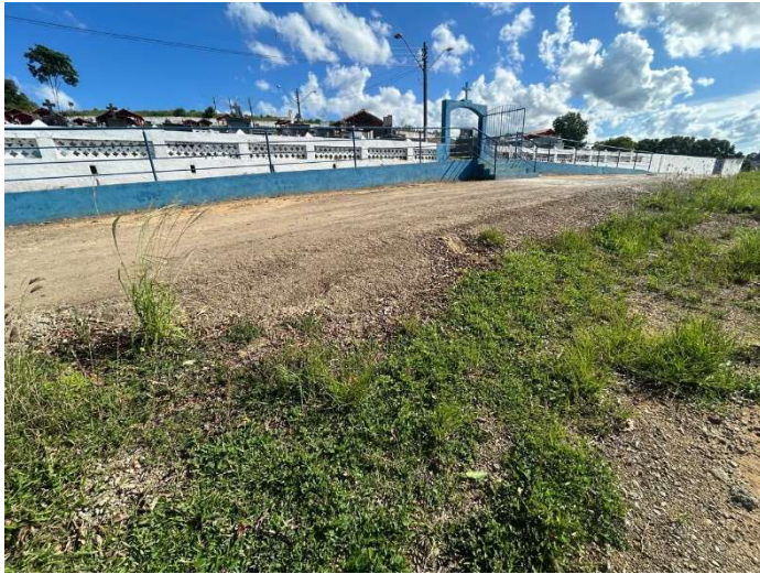
Foto 41 – Imóvel avaliando; porção da gleba a ser desapropriada. Fonte: Arquivo pessoal – Data: 02/02/2026.
