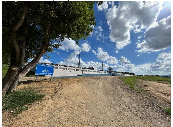
Foto 4 – Imóvel avaliando; porção da gleba a ser desapropriada. Fonte: Arquivo pessoal – Data: 02/02/2026.
