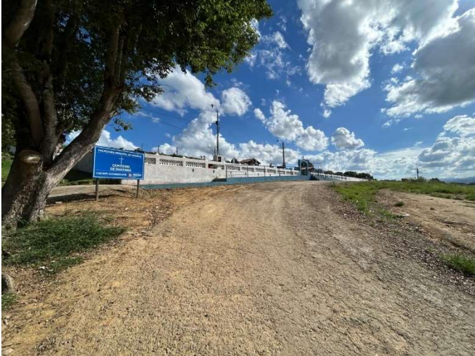
Foto 1 – Imóvel avaliando; porção da gleba a ser desapropriada. Fonte: Arquivo pessoal – Data: 02/02/2026.
