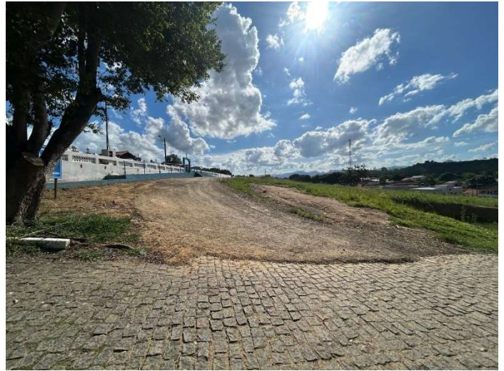
Foto 42 – Imóvel avaliando; porção da gleba a ser desapropriada. Fonte: Arquivo pessoal – Data: 02/02/2026.
