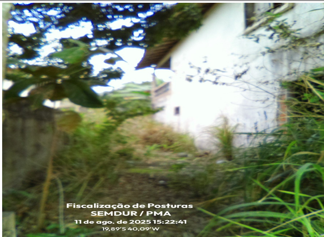
Foto/Imagem 04 [TABLET M8]: Vista parcial do local dos fatos. Lote/terreno/imóvel Inscrição 06.01.018.0523.001 [Q. 0 – L. 0] – Rua Raphael José dos Santos, Barra do Sahy/Aracruz.
