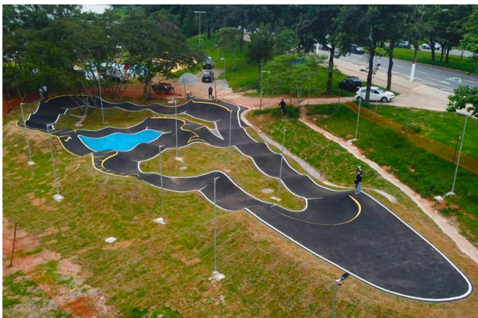
Pista de Pump Track do Jardim São Miguel
