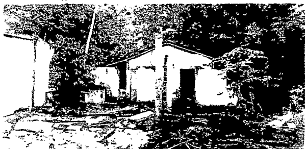
Foto 31 – Vista geral da edificação 2 (ao fundo), justaposta à edificação 1 (à frente, desabada) – Data: 05/08/2020 – Fonte: Arquivo SEMOB.
