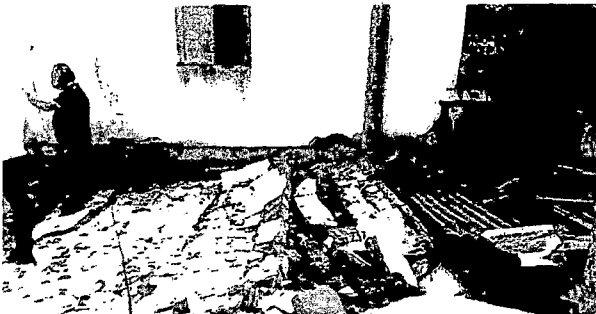
Foto 7 – Vista geral da edificação 1, que sofreu desabamento –
