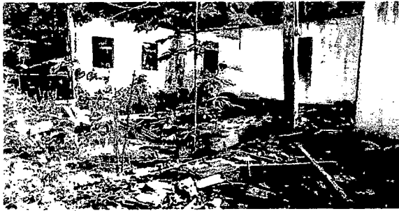
Foto 3 – Vista geral da edificação 1, que sofreu desabamento –
