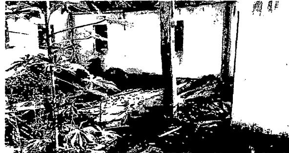
Foto 6 – Vista geral da edificação 1, que sofreu desabamento –
